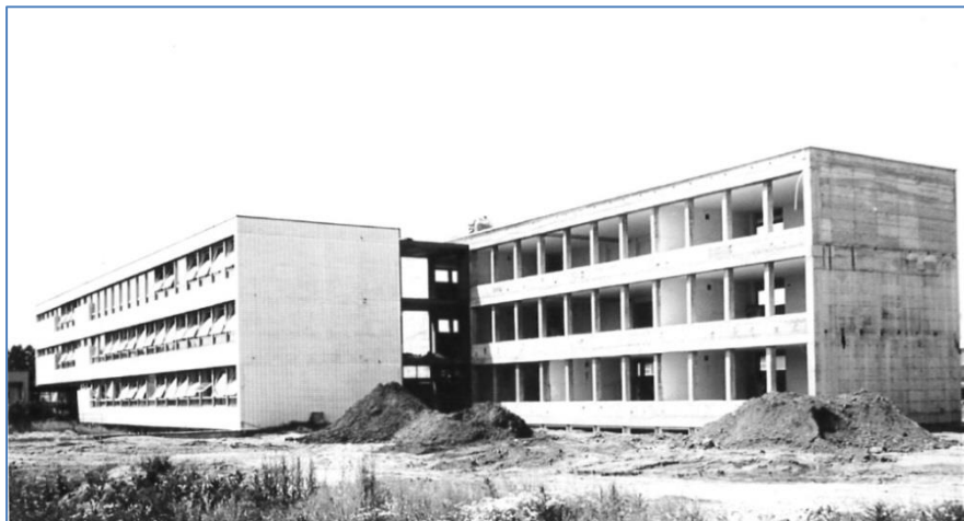
31 Der B-Trakt kurz vor dem Richtfest - Schularchiv
